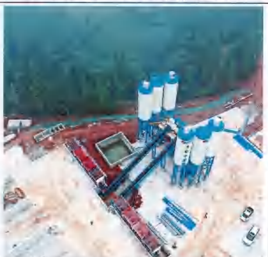
桐子坝拌合站边坡临时防护
