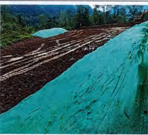
长岗岭隧洞出口临时堆土遮盖
