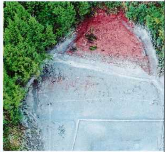
云雾寨隧洞出口截水沟
