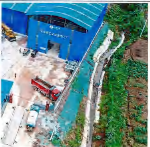
施工生产生活区边坡临时防护
