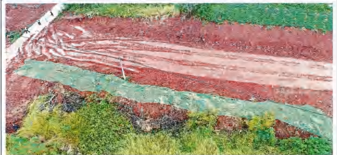
桐子坝渡槽临时防护
