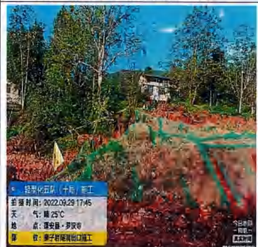
狮子岩隧洞出口施工道路临时防护
