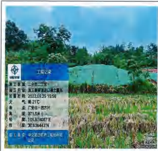
龙王寨隧洞入口表土堆放及防护
