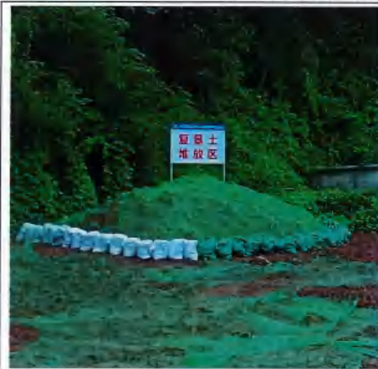
高家湾隧洞入口表土堆放及防护
