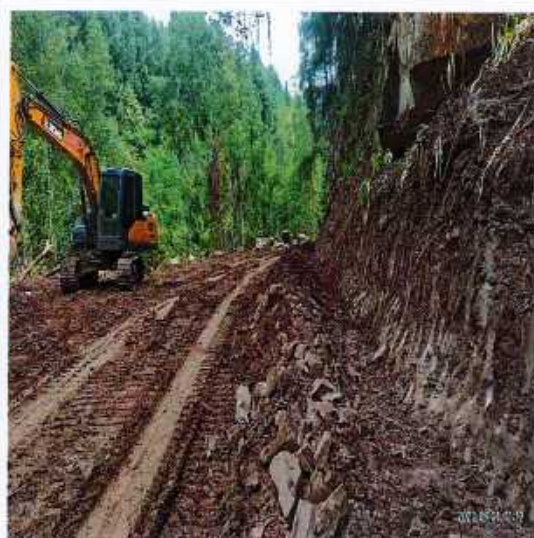
小梁咀隧洞施工道路临时排水沟修建
