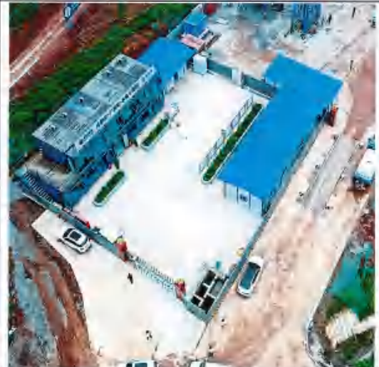
金鸡梁支洞施工生产生活区排水系统
