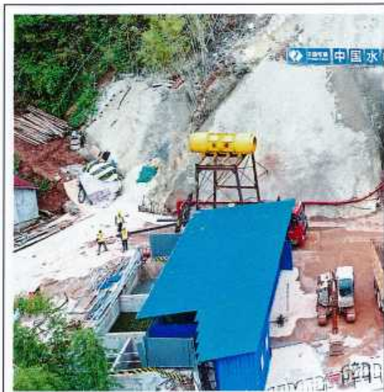
金鸡梁支洞隧洞沉砂池
