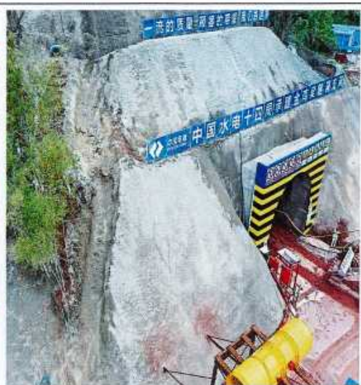
金鸡梁支洞隧洞截水沟
