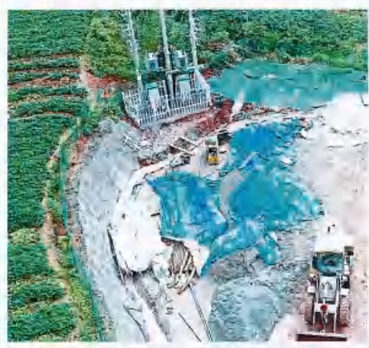
李子峡支洞施工生产生活区临时遮盖
