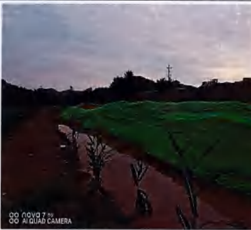
观音寺渡槽施工生活区临时遮盖
