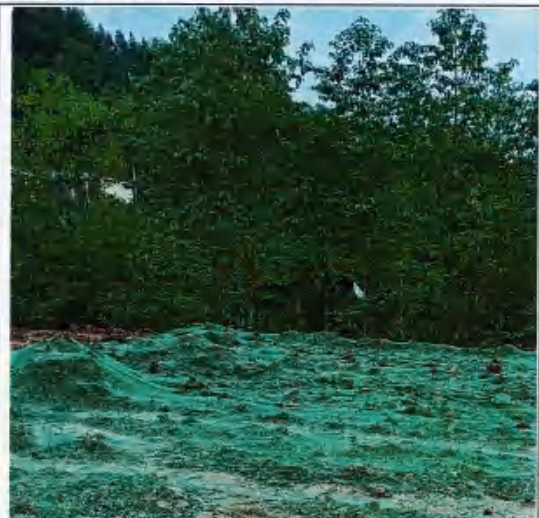
高家湾隧洞入口裸露地表临时遮盖
