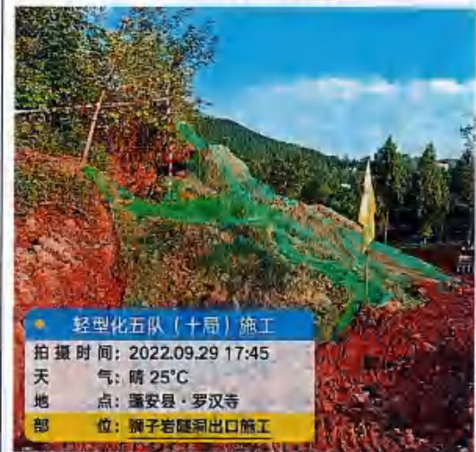
狮子岩隧洞出口施工道路临时防护
