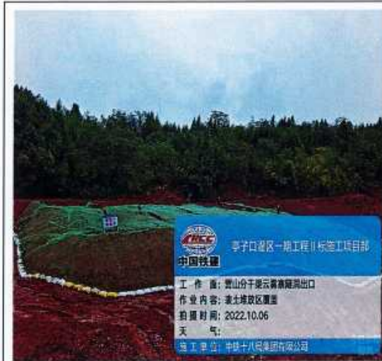
云雾寨隧洞出口表土堆放及防护
