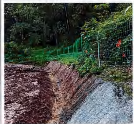
李子峡支洞施工生产生活区临时排水沟
