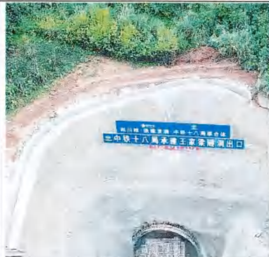
王家梁隧洞出口截水沟
