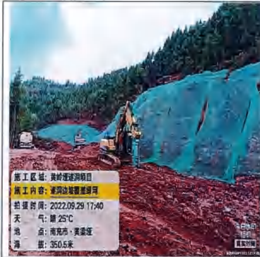
隧洞边坡临时防护
