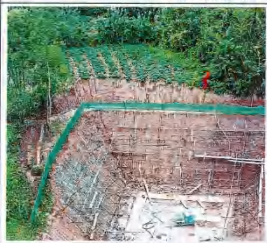
龙王寨隧洞入口截水沟
