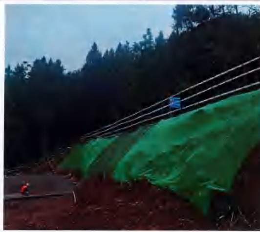
二郎山隧洞入口边坡遮盖
