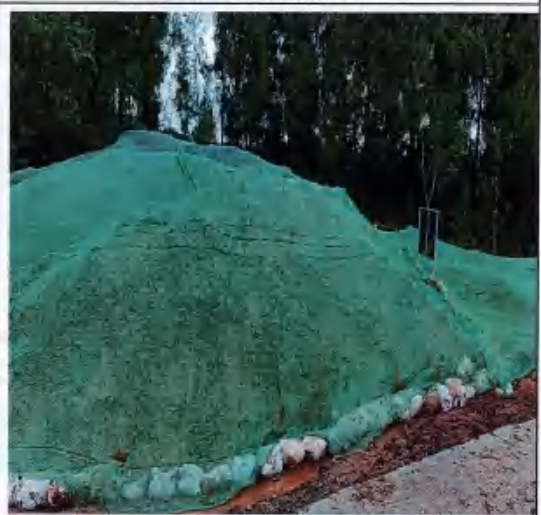
王家梁隧洞出口表土堆放及防护
