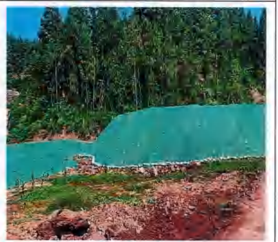
东干 2-4-1 渣场临时防护
