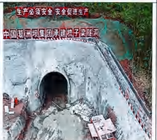
梳子梁隧洞出口截水沟
