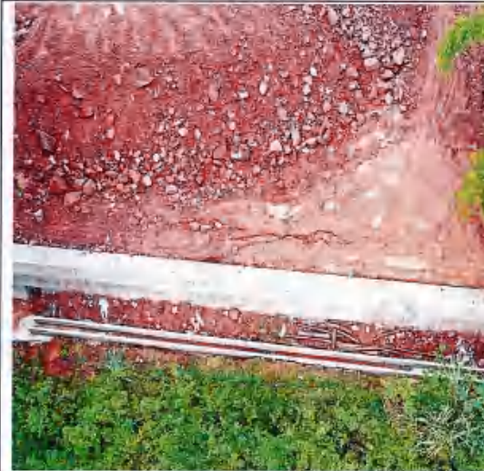
总干 8-13#渣场底部排水沟
