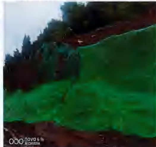
东干 2-2 渣场边坡遮盖
