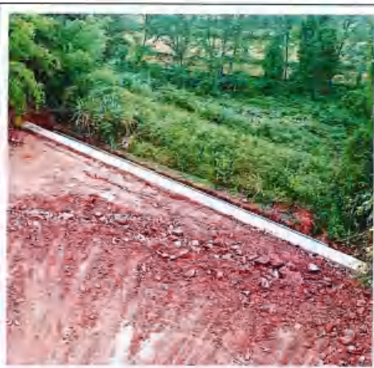
总干 8-13#渣场底部挡墙
