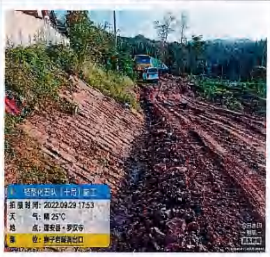
狮子岩隧洞出口施工道路临时排水沟
