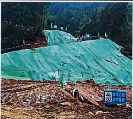
长岗岭 3#支洞边坡遮盖
