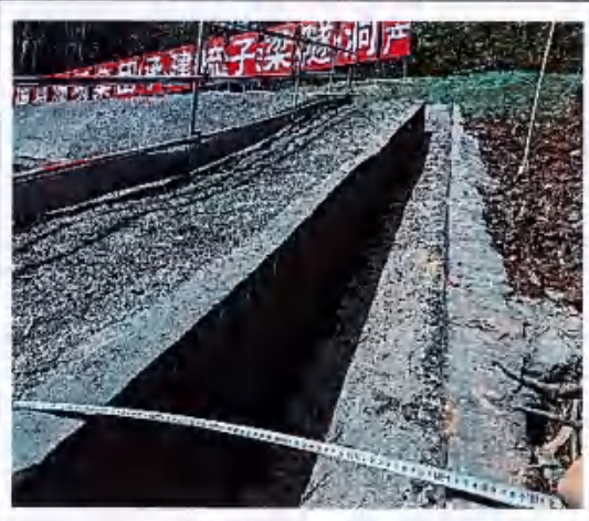
梳子梁隧洞出口截水沟量测
