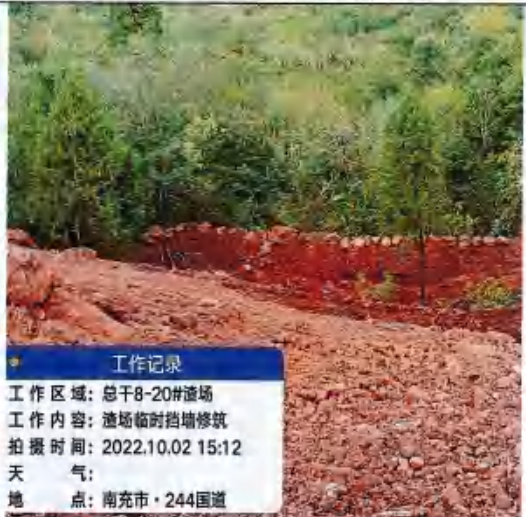
总干 8-20#渣场底部临时挡墙
