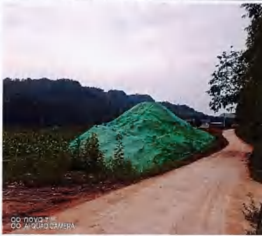
观音寺渡槽表土堆放及防护
