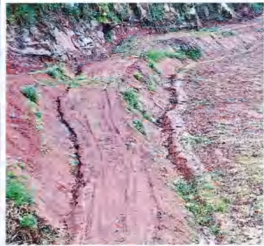
东干 2-4-1 渣场临时排水沟
