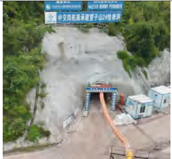
望子山隧洞 2#施工支洞
