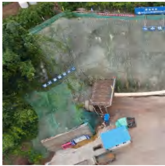
青杠寨隧洞出口
