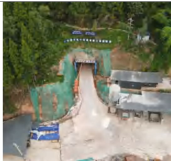
大星寨隧洞入口
