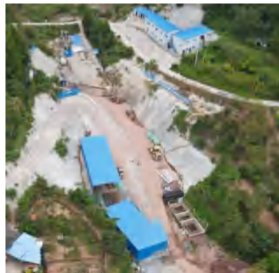
八角庙隧洞施工生产生活区
