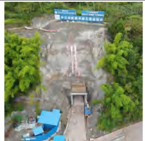
五通庙隧洞出口
