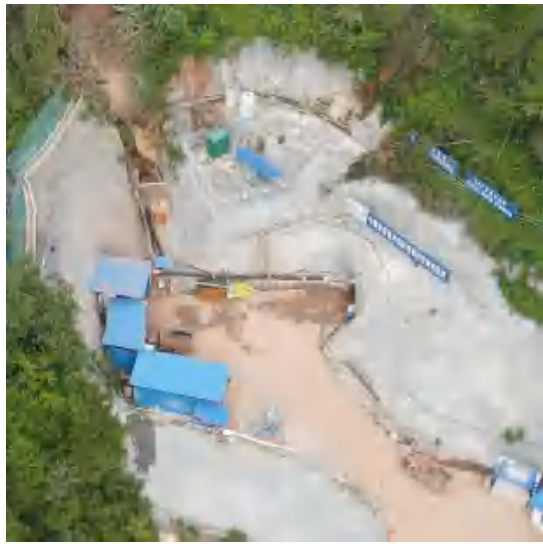
花碑坡隧洞入口+四方寨隧洞出口
