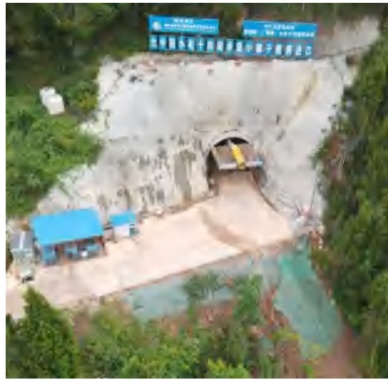
小寨子隧洞入口
