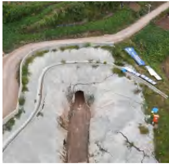
中间院子隧洞出口
