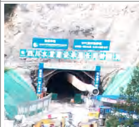
长岗岭隧洞出口
