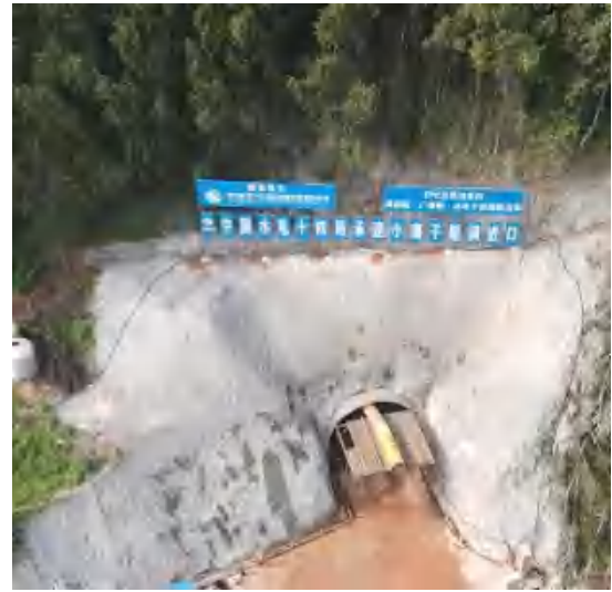
小寨子隧洞入口
