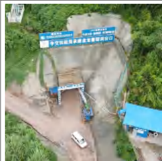
盘龙寨隧洞出口
