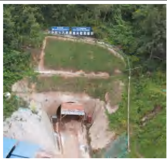
尖咀梁隧洞入口
