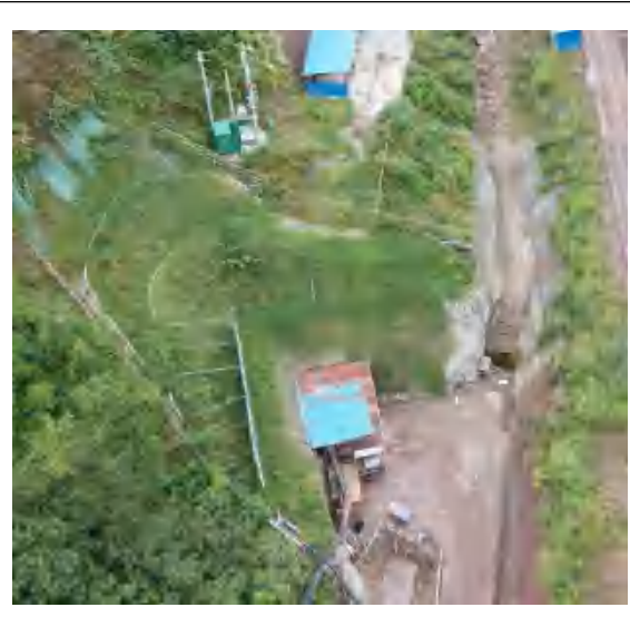
龙王寨隧洞出口
