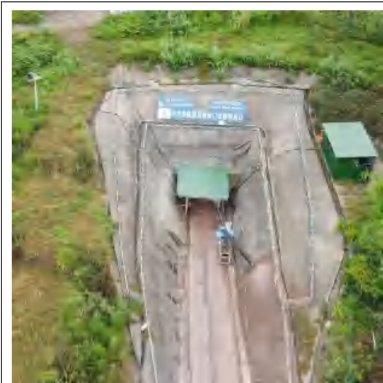
铁门坎隧洞入口
