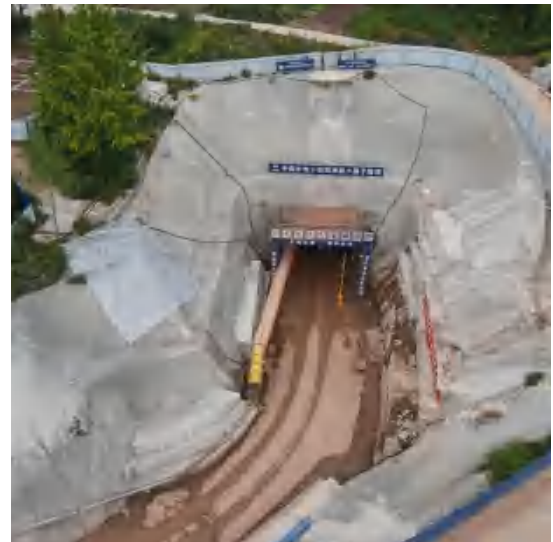
小寨子隧洞出口
