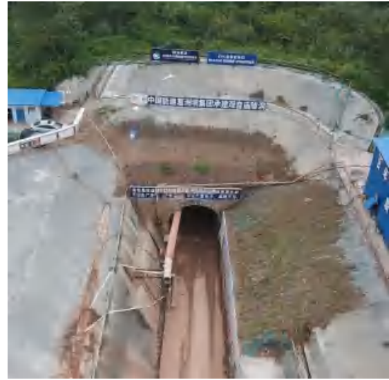
观音庙隧洞入口
