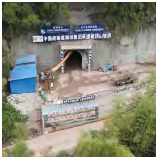
轿顶山隧洞出口
