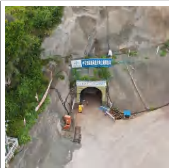
大岭上隧洞出口
