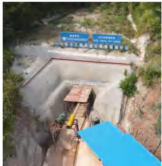
云雾寨隧洞出口
