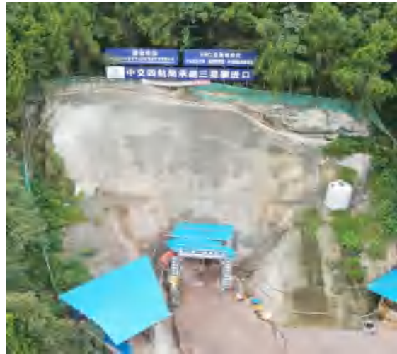
三星寨隧洞入口
