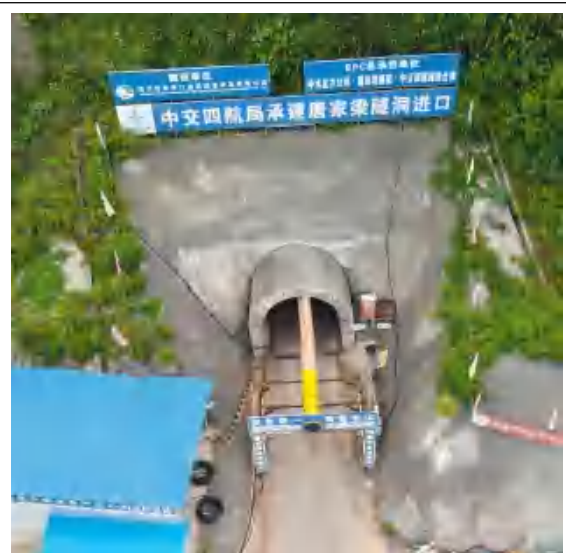
唐家梁隧洞进口
