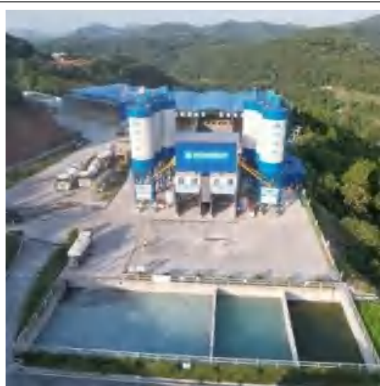
石板滩拌合站
