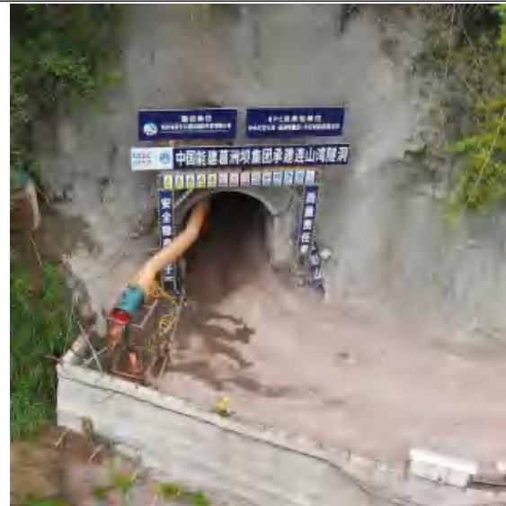
连山湾隧洞入口
