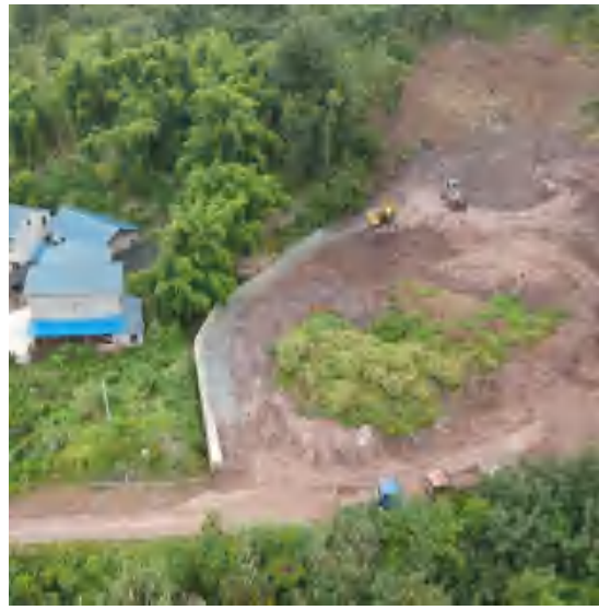
东干 5-2#渣场(下方离民房太近，存在安全隐患，建议拆除民房或另选渣场)
