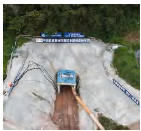
卯梁坡隧洞入口
