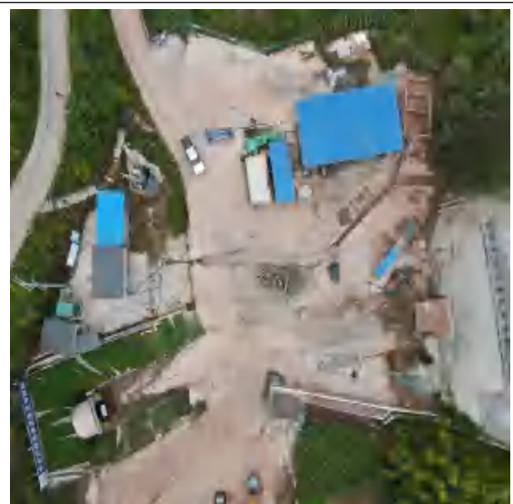
猫儿沟隧洞出口-普光寺隧洞入口
