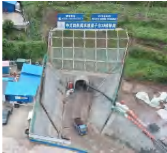
望子山隧洞 3#施工支洞
