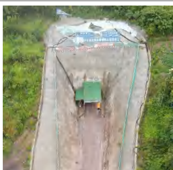
捕鸽山隧洞入口
