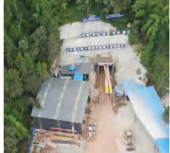
狮子岩隧洞检修洞
