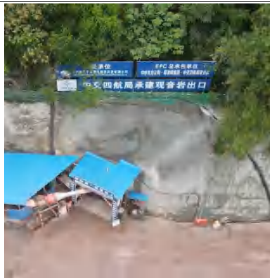
观音岩隧洞出口
