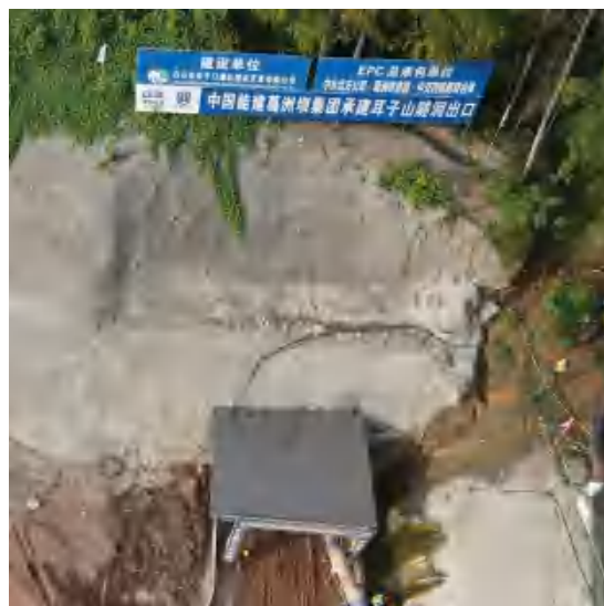
耳子山隧洞出口
