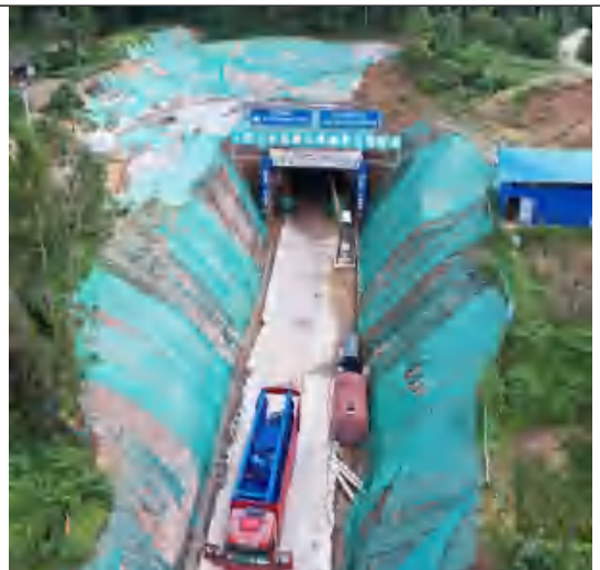
青龙咀隧洞入口
