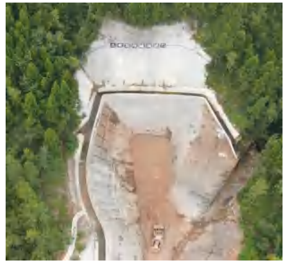
夜花坪隧洞入口
