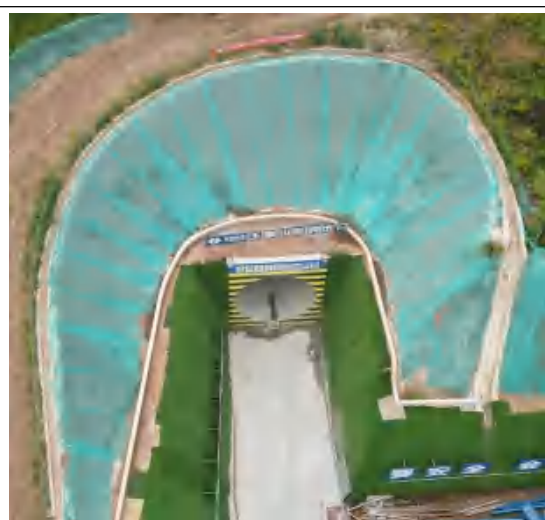
王家山隧洞出口
