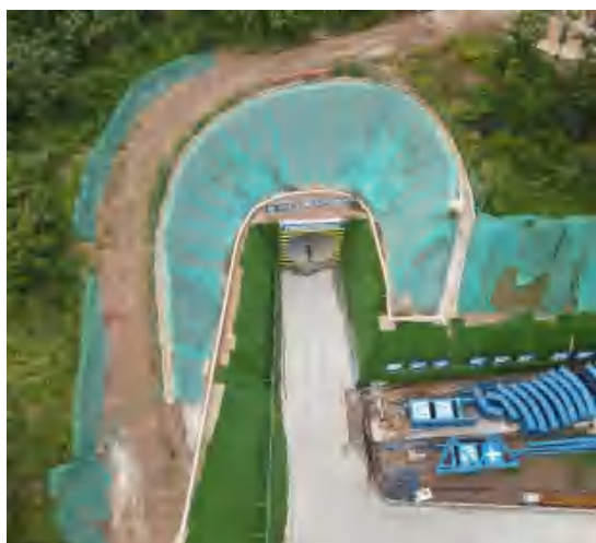
王家山隧洞出口
