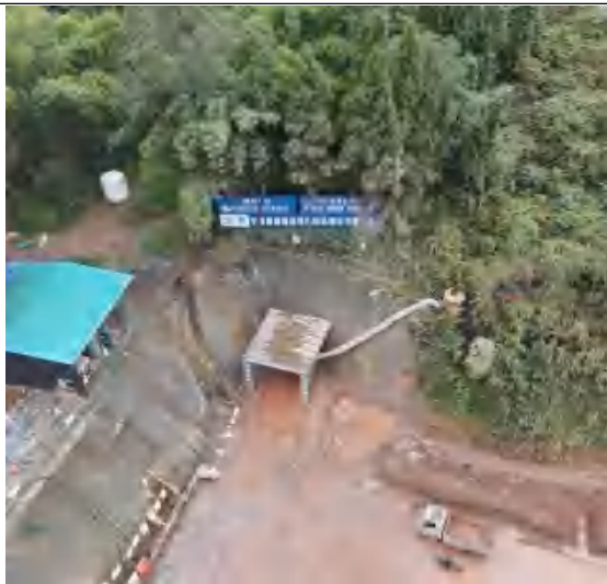
四方寨隧洞入口
