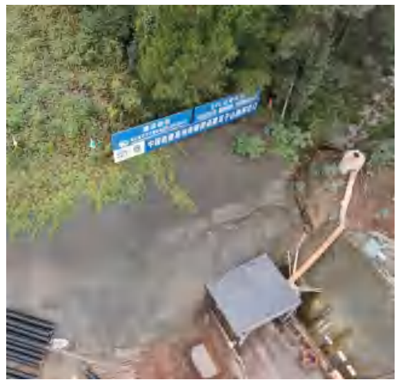
耳子山隧洞出口
