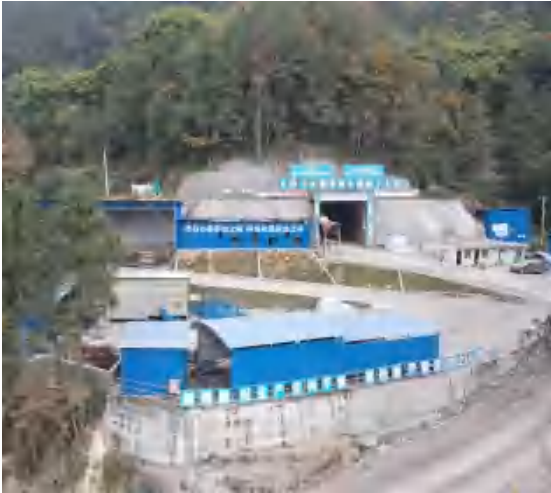
长岗岭隧洞 3#支洞
