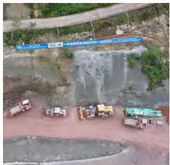
八角庙隧洞入口
