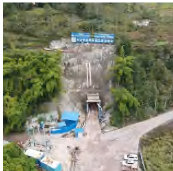
五通庙隧洞出口
