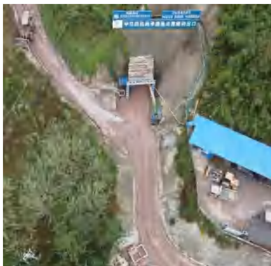
盘龙寨隧洞出口
