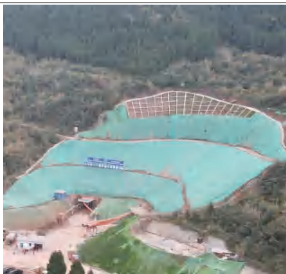
云雾寨隧洞进口
