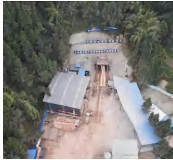
狮子岩隧洞检修洞
