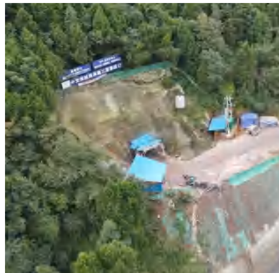
三星寨隧洞入口
