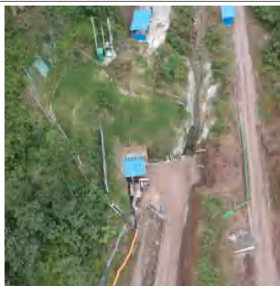
龙王寨隧洞出口
