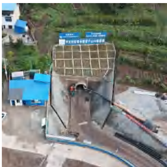
望子山隧洞 3#施工支洞
