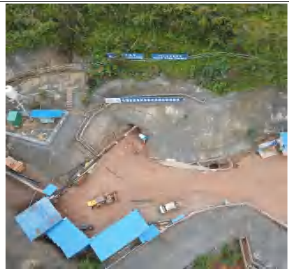
花碑坡隧洞入口+四方寨隧洞出口
