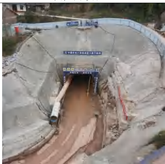
小寨子隧洞出口
