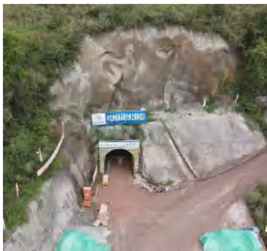
大岭上隧洞出口
