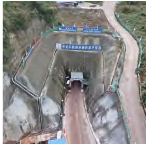
向家坪隧洞入口
