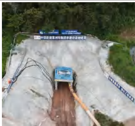
卯梁坡隧洞入口
