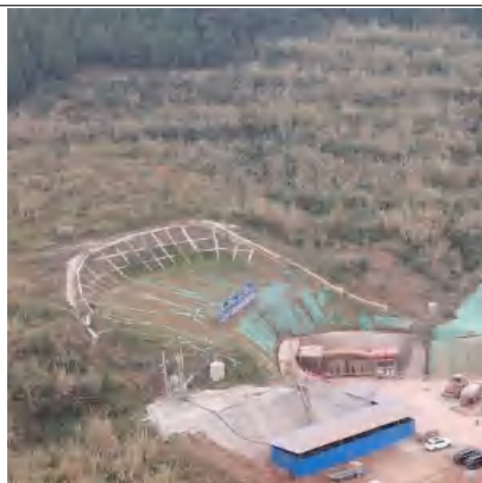
母猪寨隧洞出口
