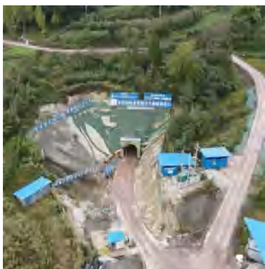
龙王寨隧洞入口
