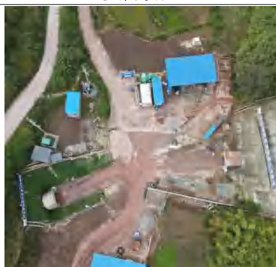
猫儿沟隧洞出口-普光寺隧洞入口
