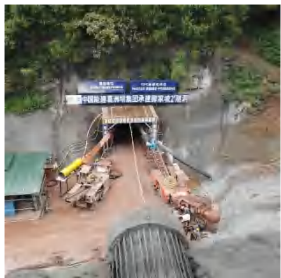
腾家坡 2#隧洞出口
