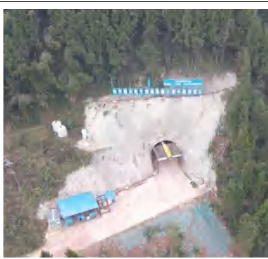
小寨子隧洞入口
