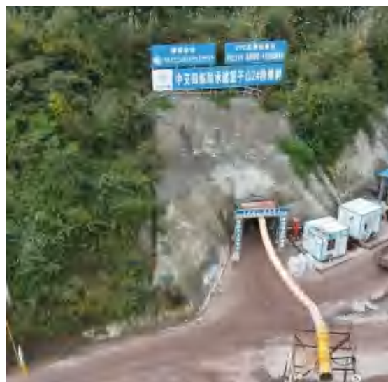
望子山隧洞 2#施工支洞
