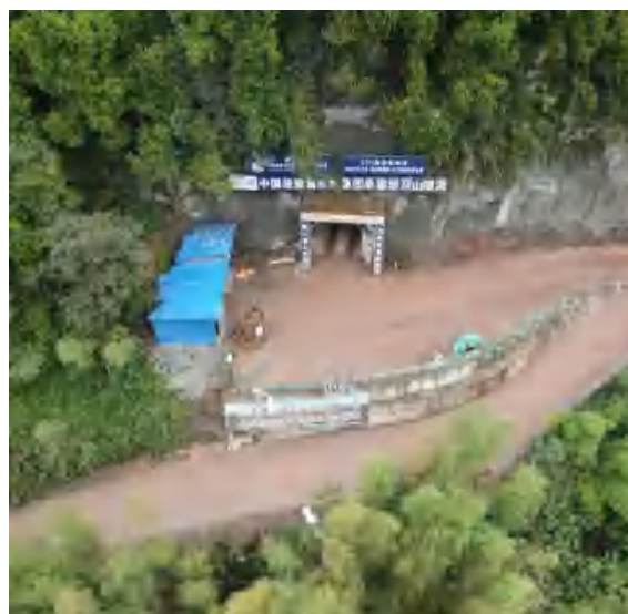
轿顶山隧洞出口
