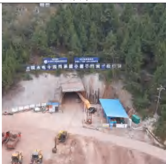
小寨子 1#检修洞
