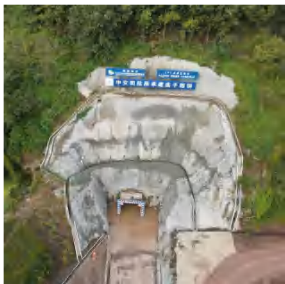
庙子隧洞出口
