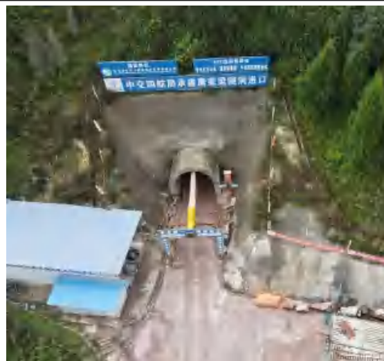
唐家梁隧洞入口
