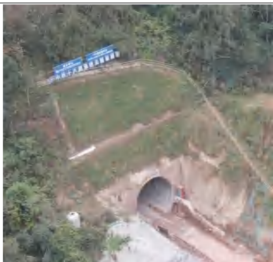
尖咀梁隧洞进口
