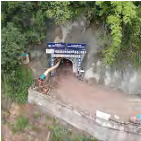
连山湾隧洞入口
